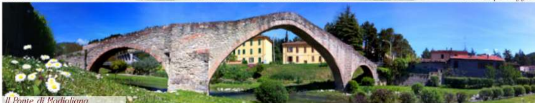
Il Ponte di Modigliana
